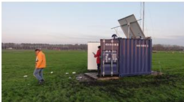
Figuur 4.10 Installatie van de meetopstelling van Intech
