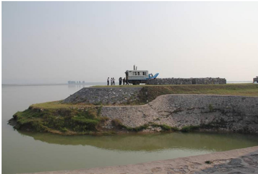
Figuur 4.52 Installatie methode van de GeoBeads op de krib
