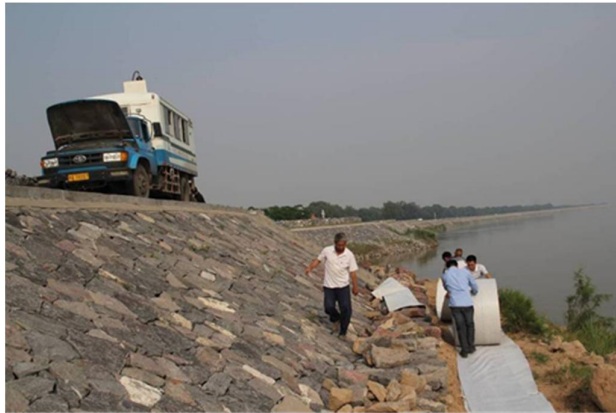
Figuur 4.54 Installatie van de optische kabel in de geotextiel en de sondeerwagen op de krib voor de installatie voor de GeoBeads
