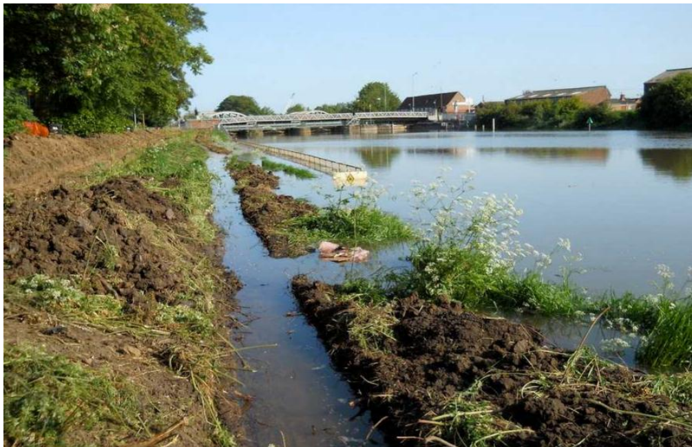
Figuur 4.56 De betreffende dijk langs "The Haven"
