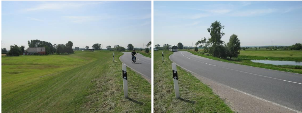
Figuur 4.60 Dijk bij laagwater (links: binnendijks, rechts: buitendijks, let op de vijver)
