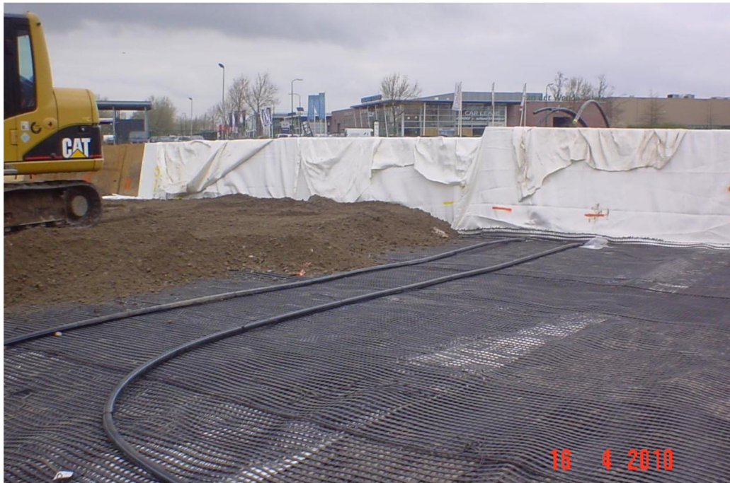
Figuur A.4 Zettingsslangen direct op de wapeningsmat [rapport Deltares: "Monitoring paalmatras Woerden A12/N204"]
