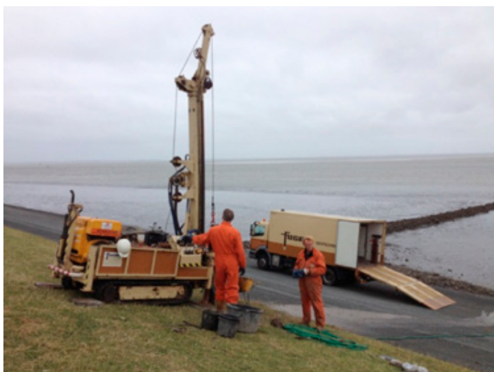
Figuur 3.5 Installatie waterspanningsmeters: diepe plaatsing met mini boorrups en plaatsing van schutkokers met Modem-Loggers
