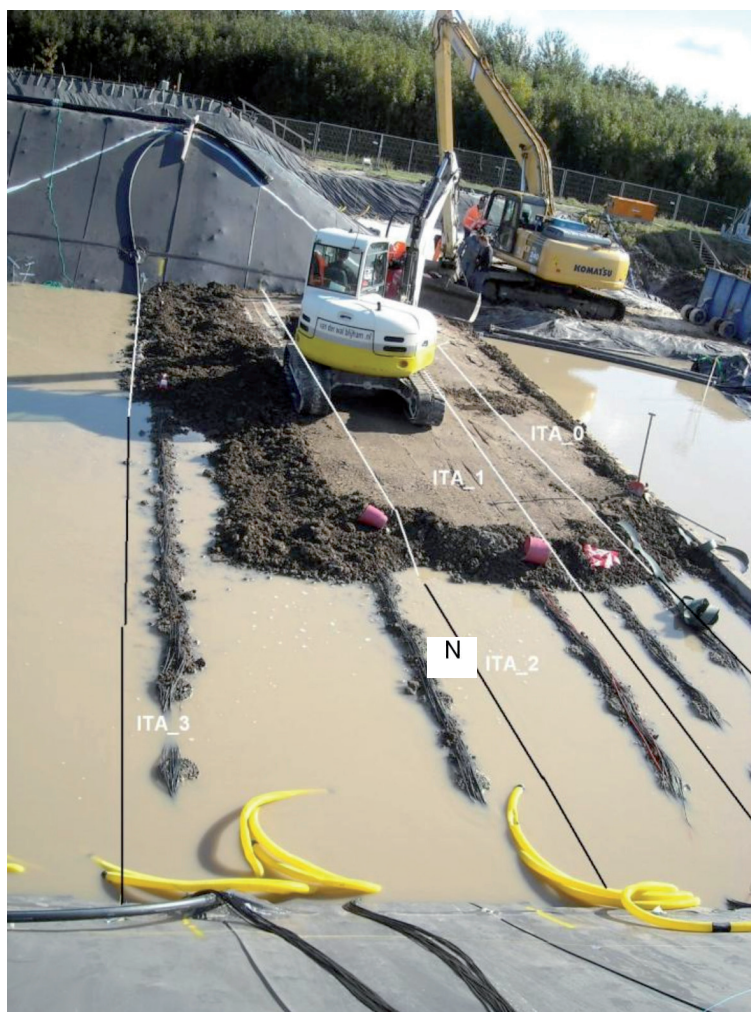
Figuur 5.8.10 Pipingexperiment 2: Aanbrengen van de optische kabels
