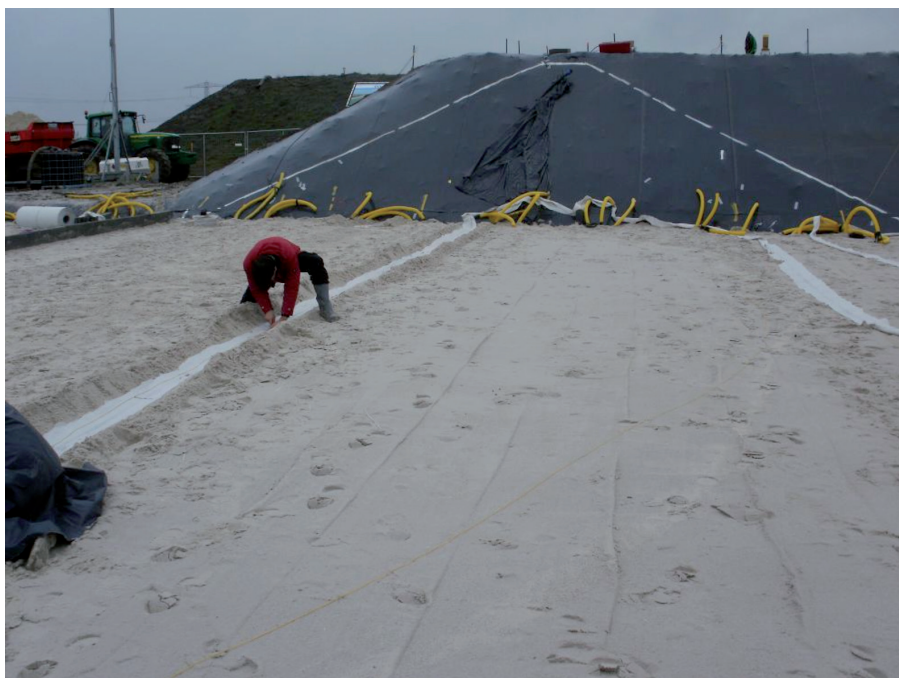
Figuur 5.8.14 Piping experiment 4: Aanbrengen van het TenCate GeoDetect® systeem in de zandlaag
