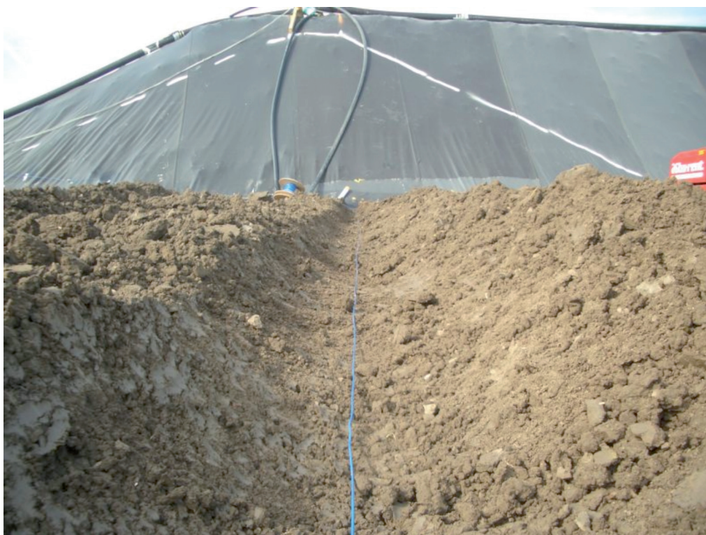
Figuur 5.4.7 Experiment 1 - fiberoptische -kabel in zand
