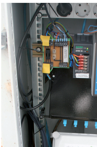
GeoBeads Junction Box voor 4 ketens GeoBeads netwerkcontroller direct op ethernet
