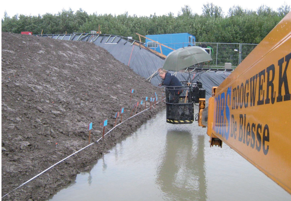
Figuur 5.10.2 Hoogwerker ter ondersteuning van de visuele inspecties
