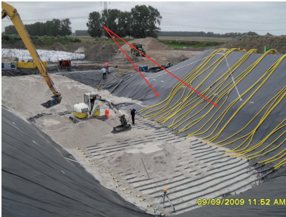
Figuur 3.12 De westelijke bak tijdens de aanleg, met de onregelmatigheden ten gevolge van de afschuiving
