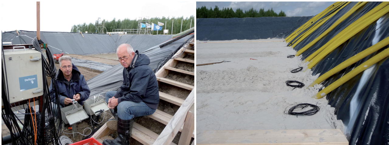
Afmonteren van detectiekabels op detectie-untis
