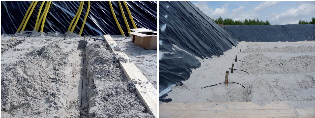
26 augustus 2009: aanbrengen detectiekabels voor pipingexperiment 1 in het zand 20 cm diep
