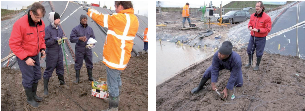
Figuur 5.9.8 Voorbereiding en plaatsing van de sensoren
