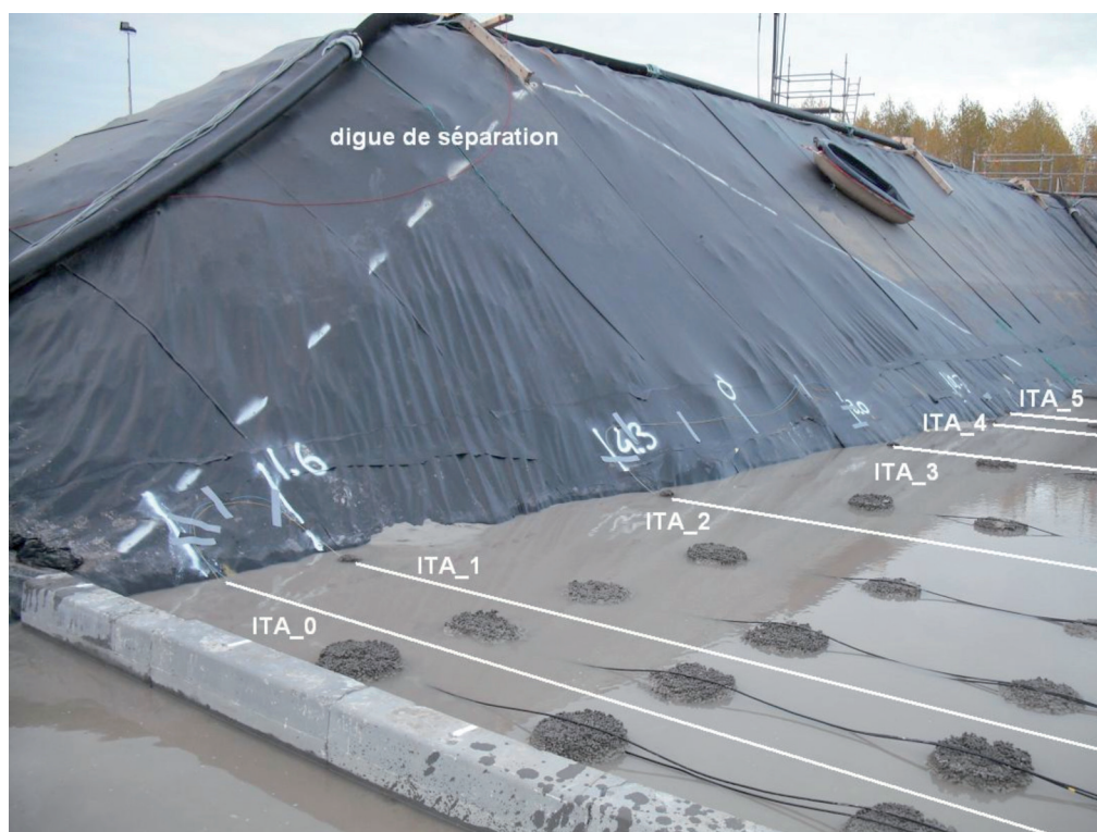
Figuur 5.8.13 Pipingexperiment 3: Posities van de optische kabel
