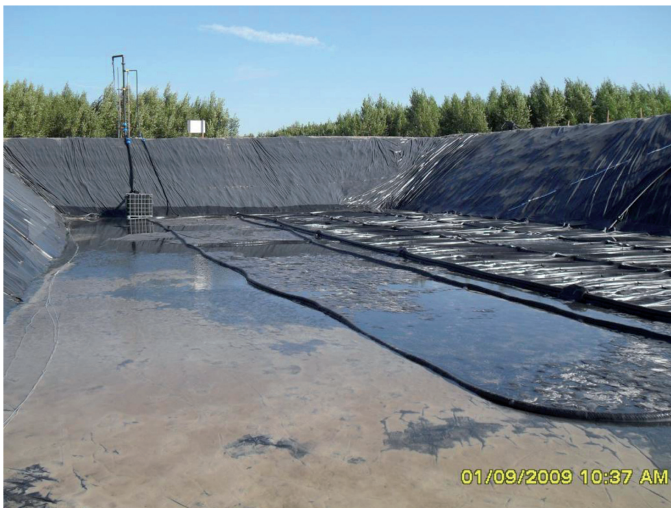
Figuur 3.14 Folie en brugconstructie voor vacuümdrainage
