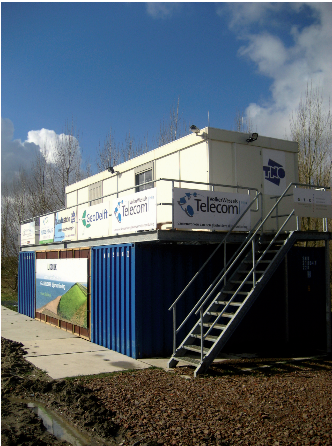
Figuur 3.17 Lokale dataopslag vond plaats in de witte container (controle kamer/meetkeet)
