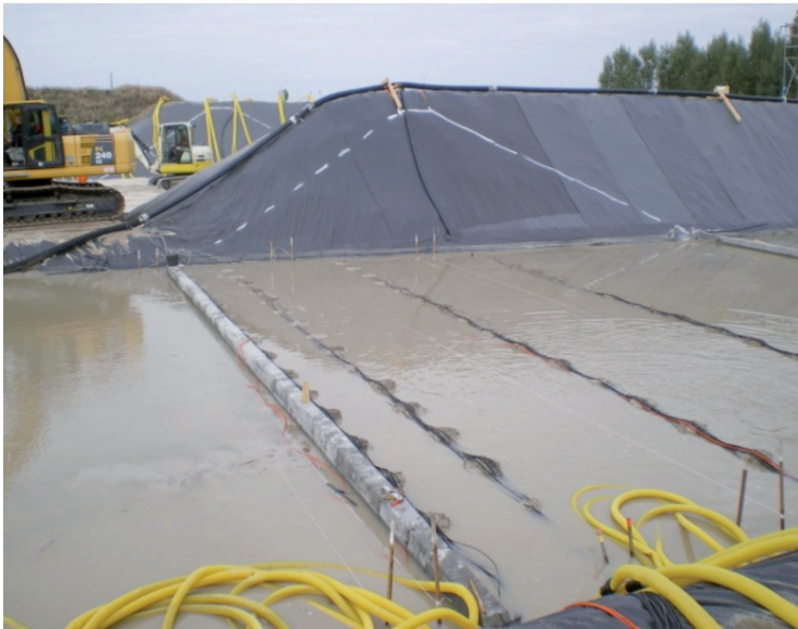
Figuur 5.8.2 Pipingexperiment 1: Installatie van de optische fiberkabel onder water in de zandlaag
