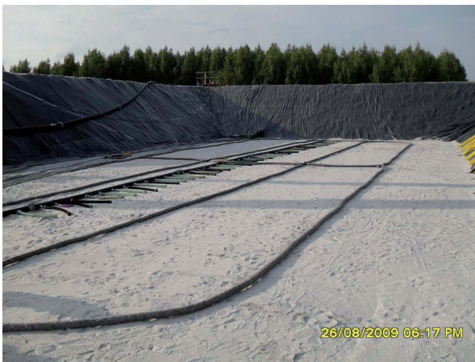
Figuur 3.13 Langsdrainage op zandpakket
