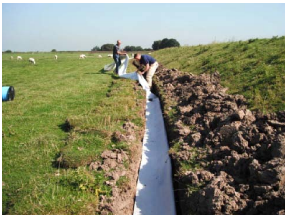
Figuur 2.1 Installatie GeoDetect (foto van TenCate)
