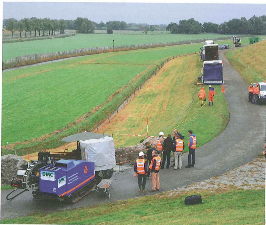
Aanbrengen van het Dijk Monitoring- en Conditioneringssysteem in de Ommelanderveedijk, september 2012.
