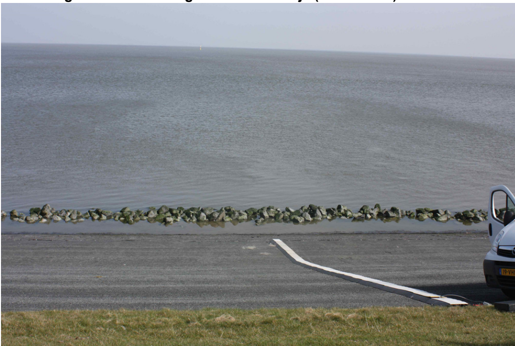
Afbeelding 2. Asfalbekleding Lauwersmeerdijk (waddenzee)
