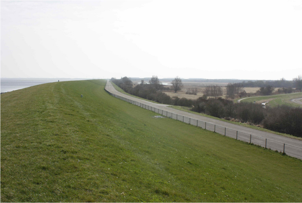
Afbeelding 5. Bovenkant Lauwersmeerdijk (oostelijke richting)
