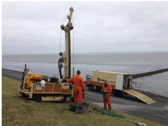
Afbeelding 4.1. Inzet mini boorrups voor de diepe plaatsingen van waterspanningsmeters in buitentalud van de dijk
