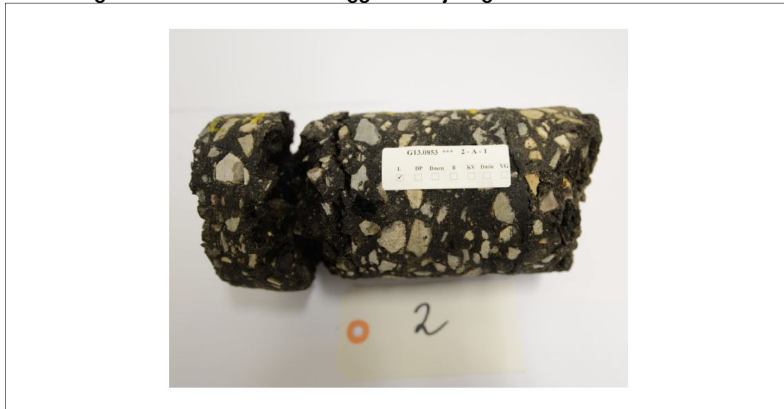
Afbeelding 5.16. Boorkern toont losliggende slijtlaag van 8 cm aan
