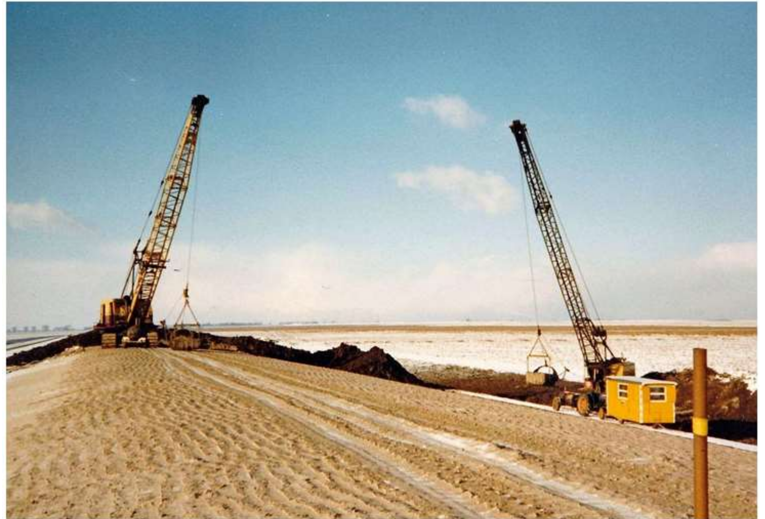
Aanbrengen kleilaag op zandlichaam (januari 1985)
