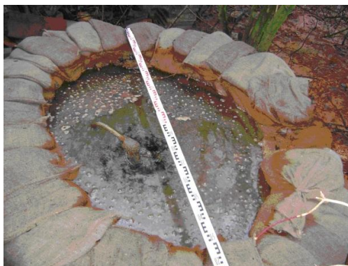
Figuur 2.1 Zandmeevoerende wellen bij een boom en een bronnering tijdens het hoogwater van januari 2011 (bron: Waterschap Rivierenland)
