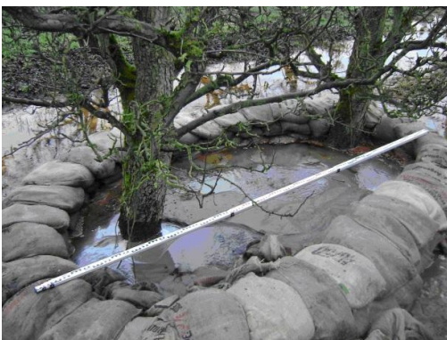
Figuur 2.1 Zandmeevoerende wellen bij een boom en een bronnering tijdens het hoogwater van januari 2011 (bron: Waterschap Rivierenland)
